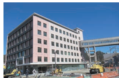
建設中のG棟
