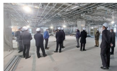
建設中のG棟を視察
